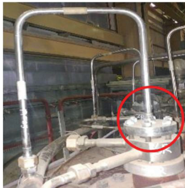
شکل ۱: لوله عصایی گازوییل و محل ترک
