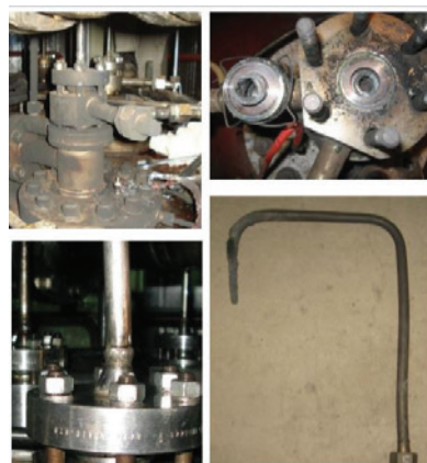
شکل ۳- آسیب دیدگی قطعات در اثر حوادث
