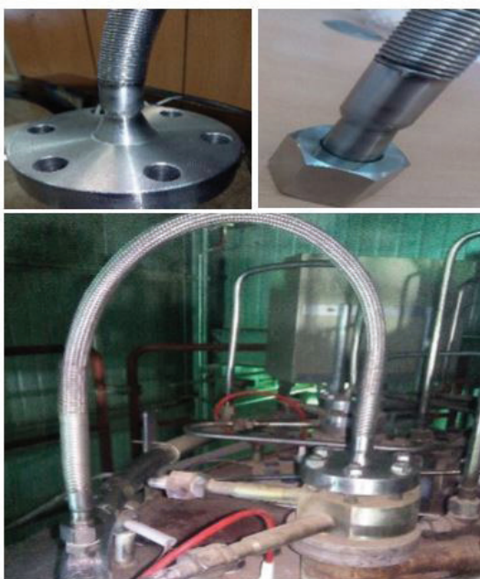
شکل ۷ - لوله فلکسیبیل نصب شده در واحد
